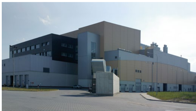
Fot. 2. Widok Zakładu Termicznego Unieszkodliwiania Odpadów od strony północno-zachodniej
